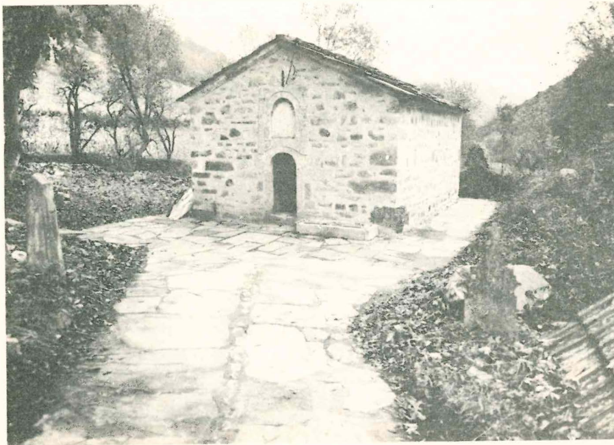
Изглед цркве св. Мине, Штава, после конзерваторско-рестаураторских радова (снимио Јован Шурдиловић)
