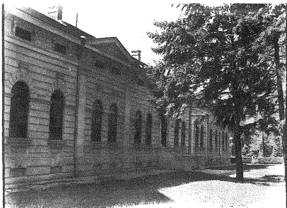
после изведених конзерваторско-реставраторских радова. (снимио: Јован Шурдиловић)
