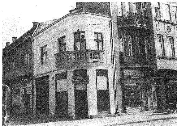
1. Зграда у ул. Копитаревеј бр. 25 на углу ул. Маршала Тита у Нишу.
