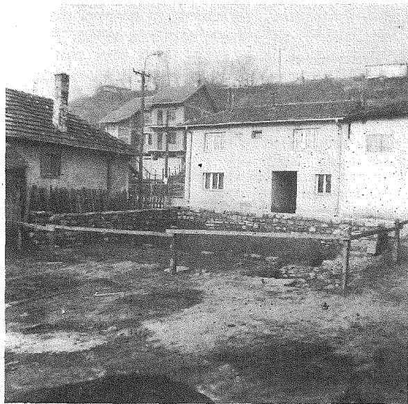
3. Изглед локалитета Митрополије у Новом Пазару после изведених радова у 1986. години, с изгледом зидања старијег објекта
