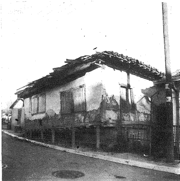
1. Објекат Митрополије у Новом Пазару, северо-западни изглед
