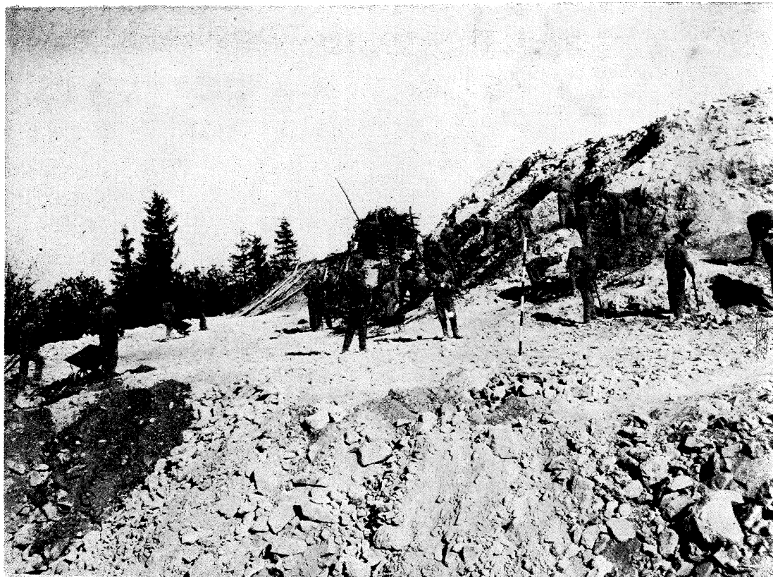
4. Жрнов на Авали 1934. — Уклањање остатака динамитом порушеног града.
