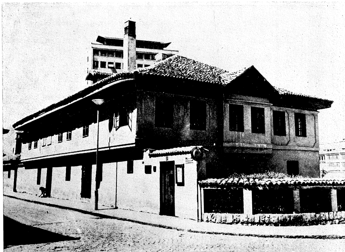
2. Доситејев лицеј у Београду, изглед после конзерваторско-рестаураторских радова
